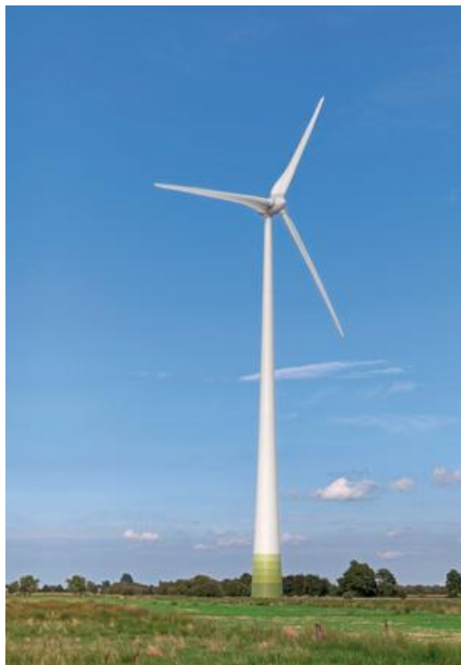
Klasse 3-5 MW (afgebeeld type: Enercon E-82; 3 MW)
